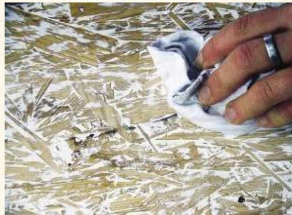
„Kalken“ von Holz und Holzwerkstoffen, hier OSB Platte. Arbeitsschritte: 1. Ausbürsten in Faserrichtung (bei OSB nicht notwendig) 2. Kasein Volltonfarbe weiß aufstreichen und mit Kunststoff- Glättspachtel abziehen 3. Schleifen und entstauben 4. Ölen oder Wachsen, hier Saflor Lappenwachs
