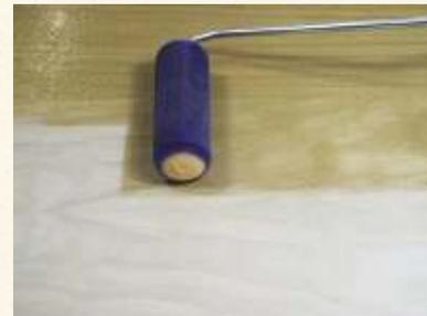
Die -pure solid- Öle werden am Besten mit Rollen aufgetragen
